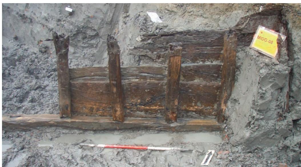
Afb. 4.1 Houten beschoeiing 'stadsdijk', waterzijde.
