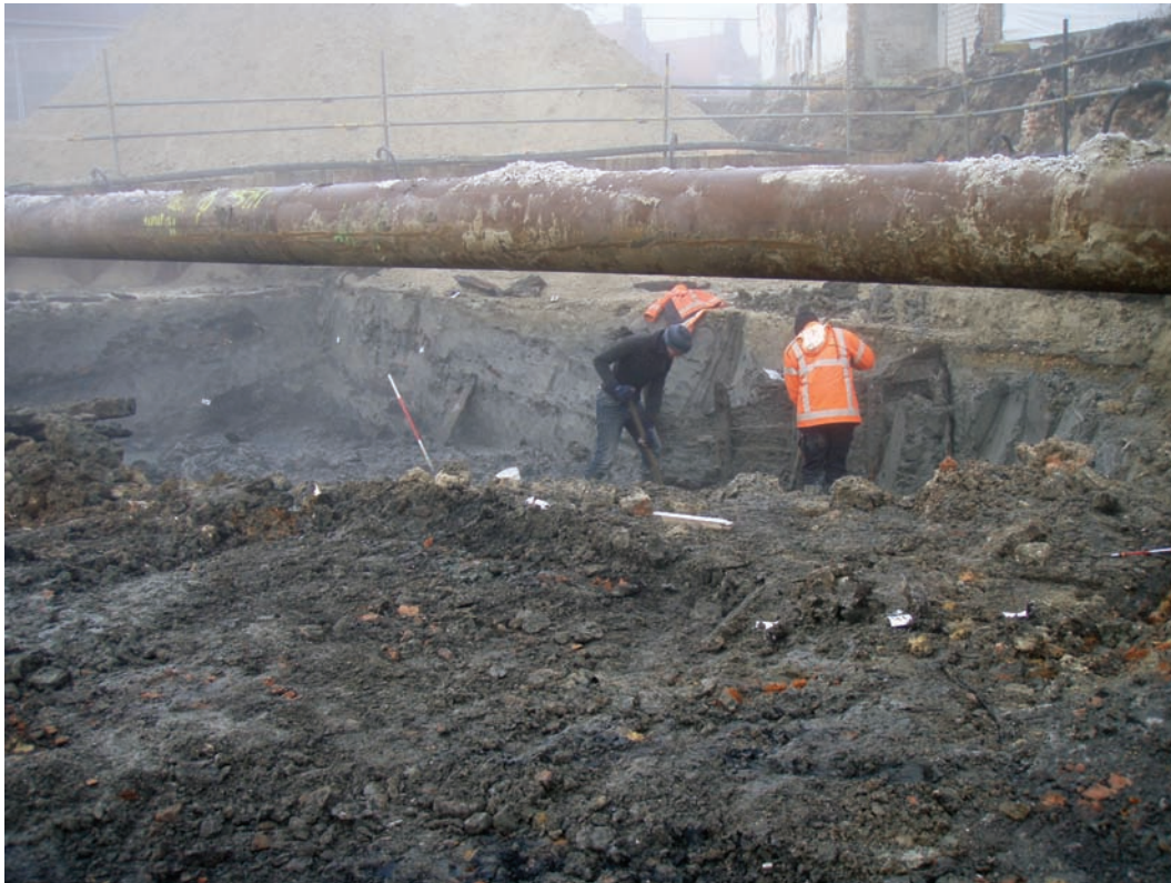
Afb. 3.1 Afsteken en schoonmaken van profielen over dijk- en wallichamen.
