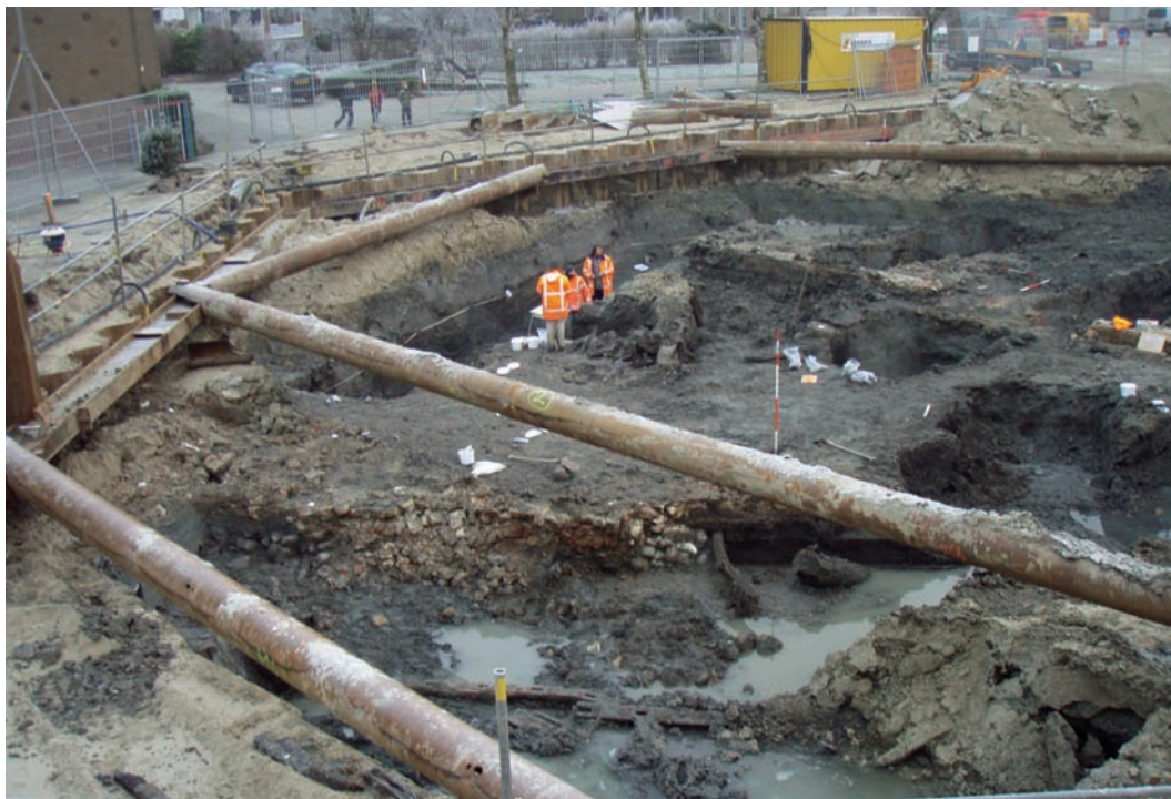
Afb. 2.3 Het onderzoek na plaatsen damwanden en stempels.
